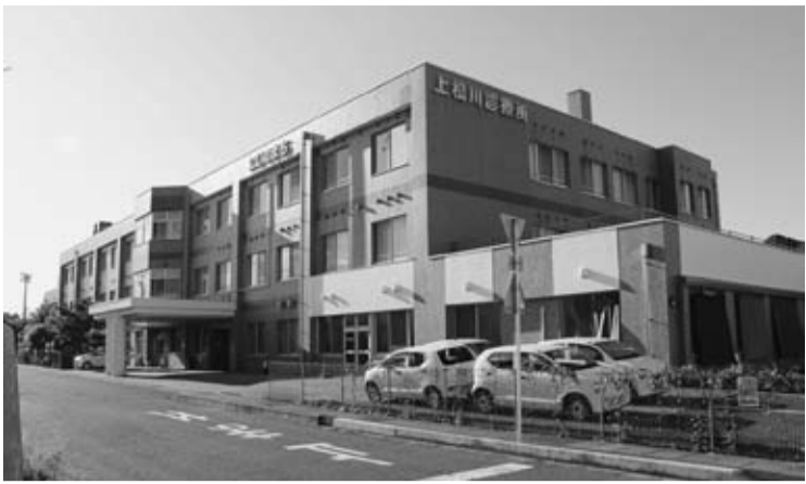
▲工事の終了したにじのまち、上松川診療所
