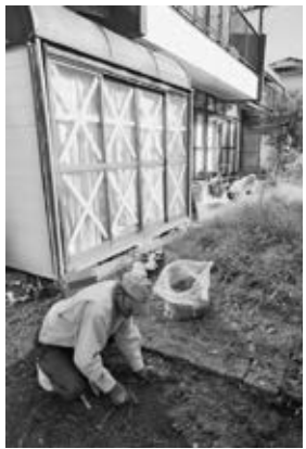
▲作業中の様子
